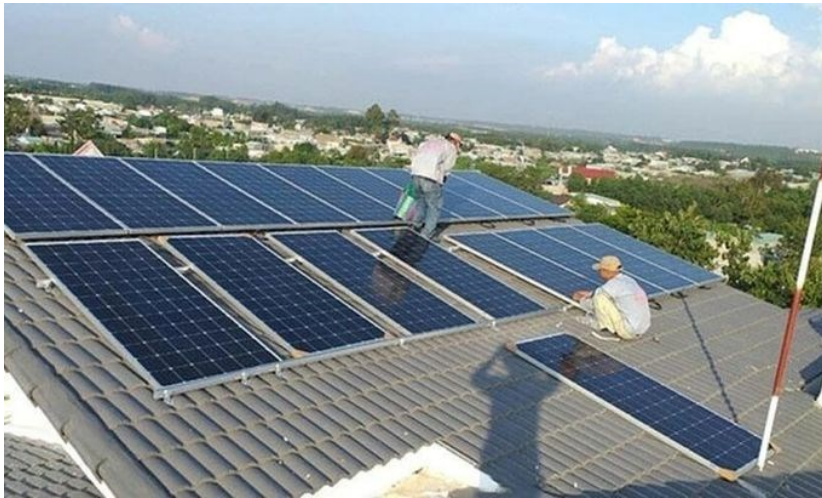
人们安装屋顶太阳能发电系统。图片来源：VNExpress
