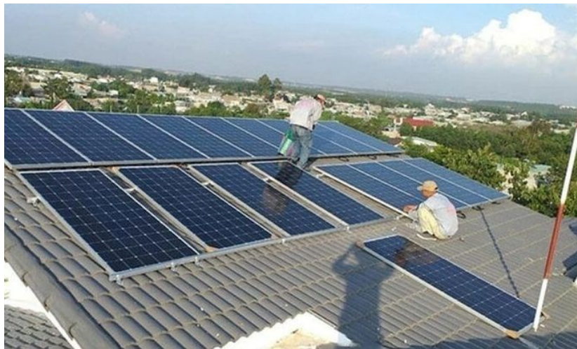
Người dân lắp đặt hệ thống điện mặt trời mái nhà. Ảnh: VGP
